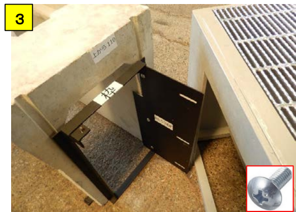
3 側溝に枠を添え置き短辺固定の穴にトラスネジを通し枠のナットに仮止める
