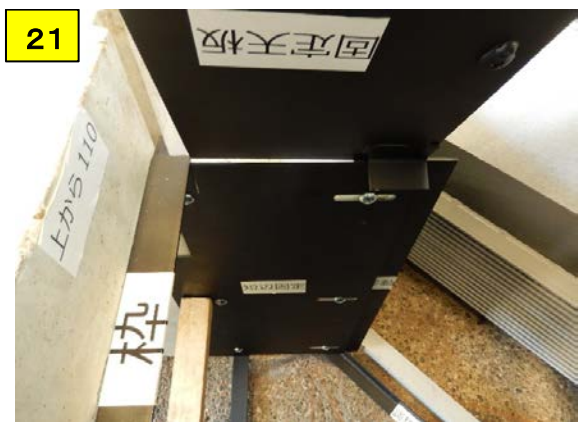
固定天板のズレ止めが短辺固定と長辺固定の 内側に入るように枠のボルトに固定天板の穴を 通し固定する
