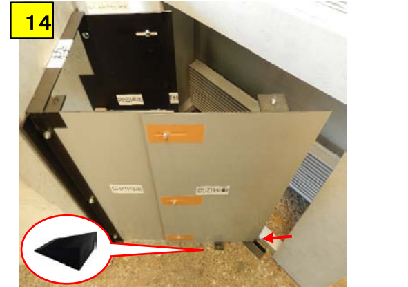
14 クサビで長辺移動の高さや位置を定めた後、長辺固定に長辺移動を取付ける 注) 調整金具の切込み部に入っている事を確
