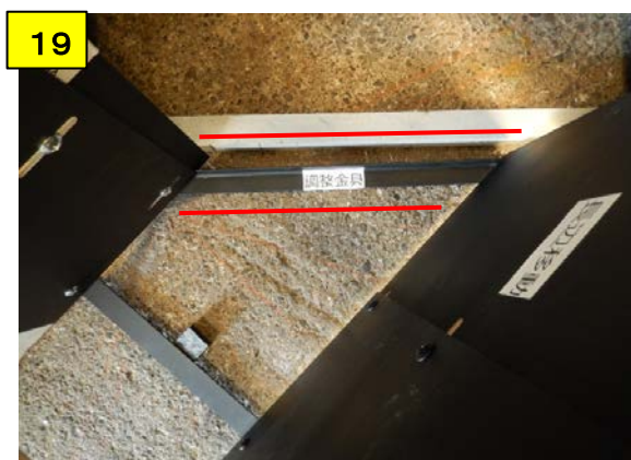
長辺移動・短辺移動・調整金具・桁の 位置関係を確認する 注)調整金具の位置は桁に平行にする
