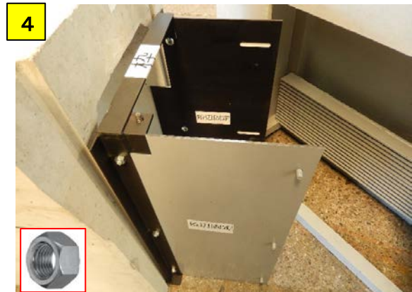
4 枠の穴に長辺固定のボルトを通しナットで仮止める
