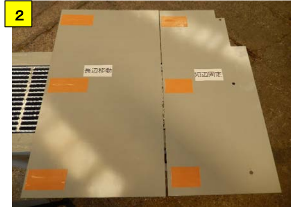
2 長辺移動と短辺移動の長穴をガムテープ等でマスキングする
