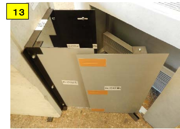
13 長辺移動を調整金具の切込み部にはめ込みおおよその位置調整をする
