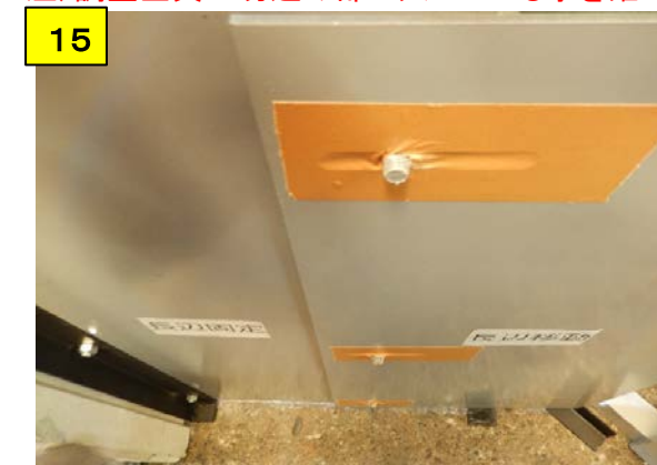
15 長辺移動の位置を再確認し、長辺固定のボルトでガムテープを突き破る
