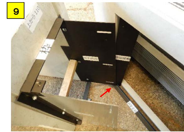
9 短辺移動を短辺固定の外側に添え置きます 注) 調整金具の切込み部に短辺移動をはめ込む
