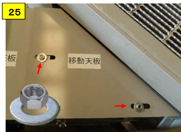
移動天板の位置が決ったらワッシャーを 入れナットでしっかり固定する
