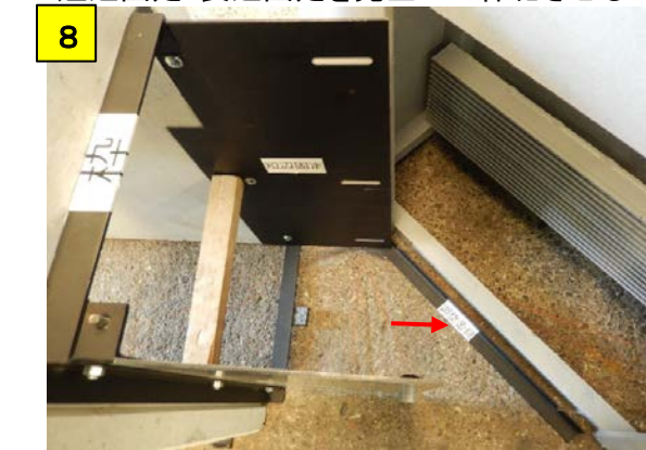
8 調整金具を桁におおよそ平行に設置します 注) 調整金具の切込み部に短辺固定が入る位置
