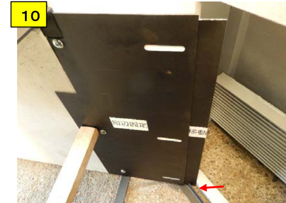
10 調整金具の切込み部に短辺移動が入り込んでいる事を確認する
