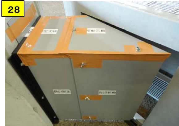
コンクリートが流入しないようにガムテープ等 でしっかり養生する
