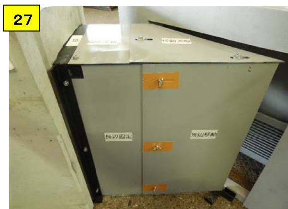
全ての位置を再調整し、確認後全ての蝶ナット ・トラスネジ・ナットをしっかり締め込む
