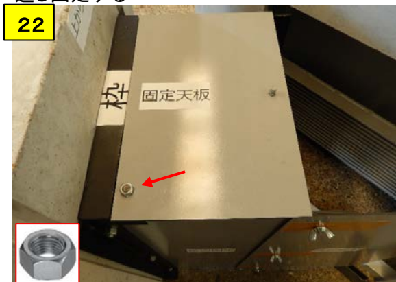
固定天板と枠をナットで固定する
