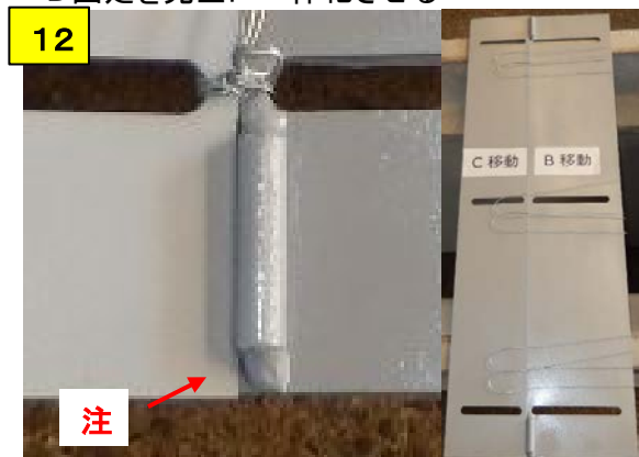
B移動の丸棒にC移動を沿わせて結束する 注) B移動の丸棒とC移動の位置を確認する
