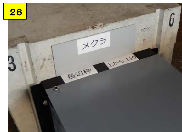
メスの部分はメクラでふさぎガムテープ等でマスキングする
