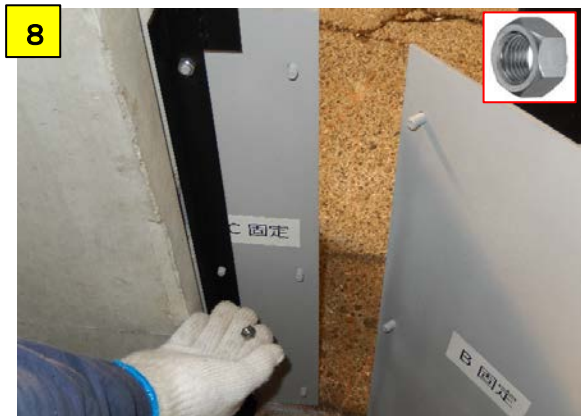
側溝に短辺枠を添え置き短辺枠の穴にC固定のボルトを通しナットで仮止めする
