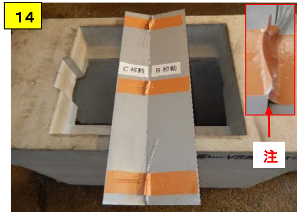
B移動とC移動の丸穴をガムテープを途中で切らずにマスキングする 注) 折り曲げる為結束線を包むようにだぶらせる
