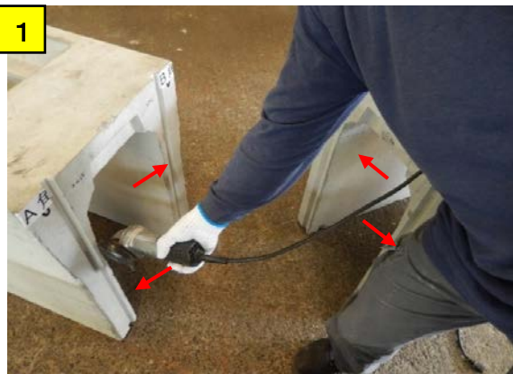
側溝の内側側面のコンクリートのバリをグラインダー等で完全にに取り除く
