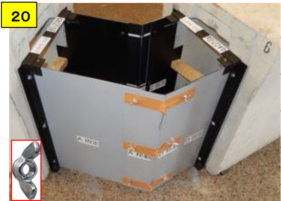
つないだA移動とD移動を指定の角度におおよそ折り畳み、位置を調整しながらA固定とD固定に蝶ナットで固定する
