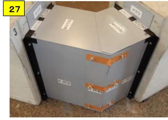
全ての位置を再調整し、確認後全ての蝶ナット・トラスネジ・ナットをしっかり締め込む
