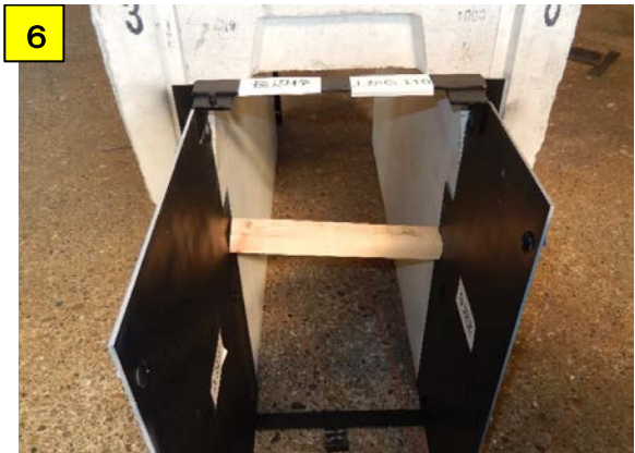
長辺枠の位置が決まったらバタ角でしっかり固定し、ナットを締め込み側溝と長辺枠・A固定・B固定を完全に一体化させる
