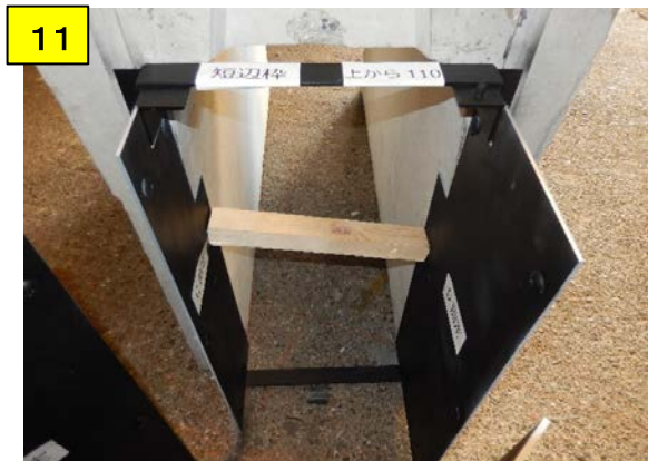
短辺枠の位置が決まったらバタ角でしっかり固定し、ナットを締め込み側溝と短辺枠・C固定・D固定を完全に一体化させる
