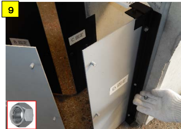
短辺枠の穴にD固定のボルトを通しナットで仮止めする
