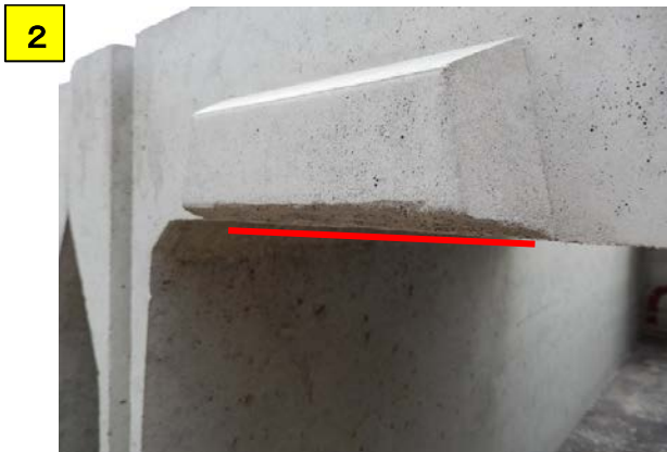
オスの下部のコンクリートのバリもグラインダー等で完全にに取り除く
