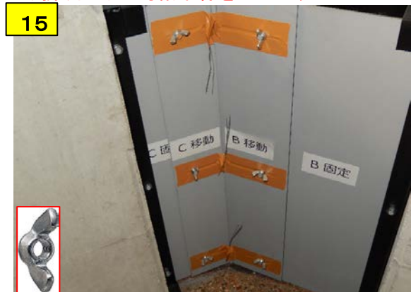
つないだB移動とC移動を指定の角度におおよ折り返し、位置を調整しながらB固定とC固定に蝶ナットで固定する
