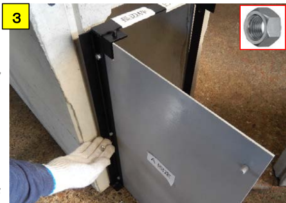
側溝に長辺枠を添え置き長辺枠の穴にA固定のボルトを通しナットで仮止めする
