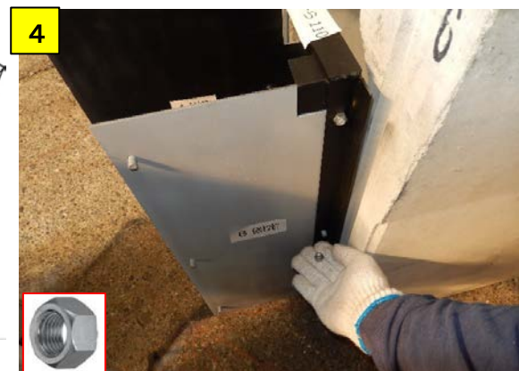
長辺枠の穴にB固定のボルトを通しナットで仮止めする
