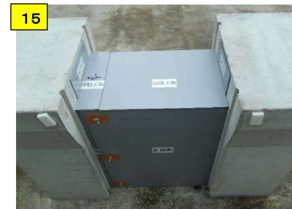
全ての位置を再調整し、確認後全ての蝶ナットをしっかり締め込む
