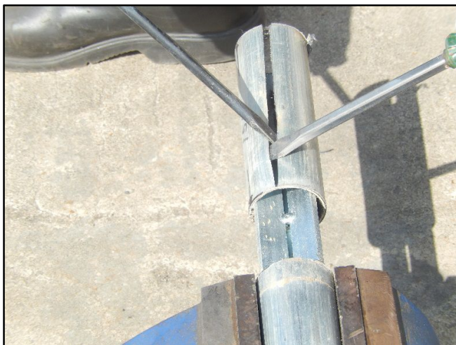
④ 工具を使い、切断部分を広げながら引抜きます
